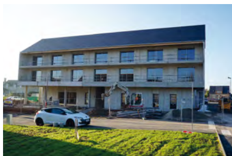
La future résidence autonomie a désormais sa toiture !
