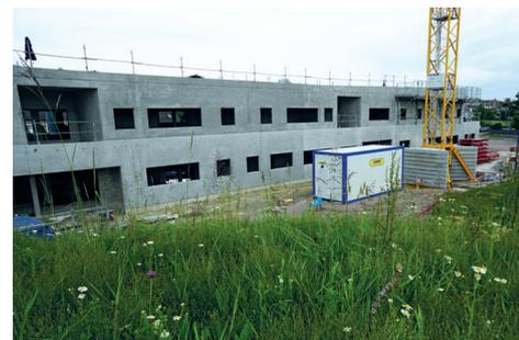
**Réunion hebdomadaire de suivi de chantier • Vue des pièces avec murs porteurs en béton : des cloisons viendront créer les couloirs et espaces de consultations • La façade côté sud.**
